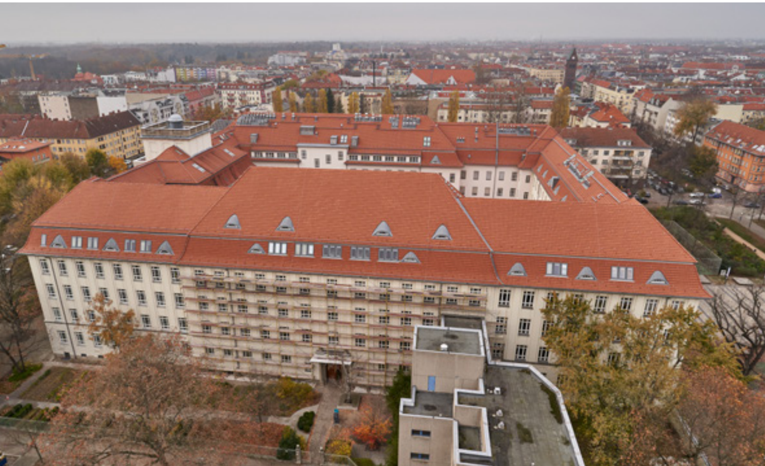
Das Haus Beuth vom Dach des Hauses Grashof aus
